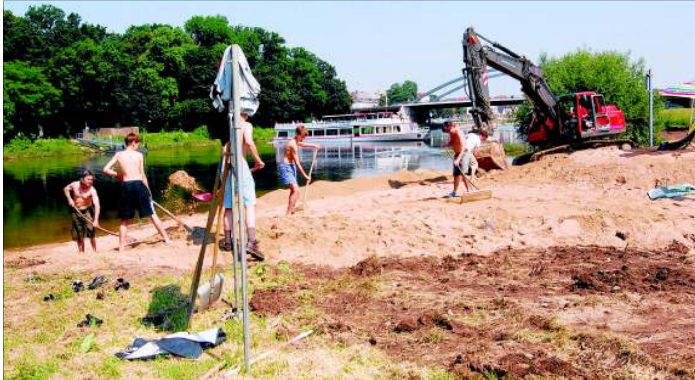
Schweißtreibend: Fleißig legten die Helfer Hand an, um den Sand am Weserufer zu verteilen. Die große Arbeit verrichtete jedoch ein Bagger. MT-Fotos: Langenkämper
